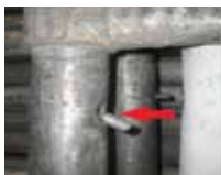
Trasig tapp på gavelräckesram
