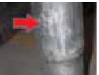
Wgniecenia i brak zacisków blokujących
