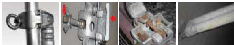
Metallikliipsien olemassaolo; kumiset jarrukengät ja putket ovat hyvässä kunnossa
